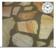
Дать средству впитаться и подсохнуть на поверхности в течении 15 - 25 минут, в зависимости от пористости поверхности, температуры основы и воздуха.
