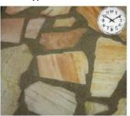
Дать средству впитаться и высохнуть на поверхности в течении 1-2 часов, в зависимости от пористости поверхности, температуры основы и воздуха.
