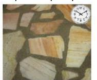
Оставить поверхность сохнуть на 24 часа перед тем, как возобновить движение по поверхности. Защитить поверхность на 24 часа от дождя и пыли.
